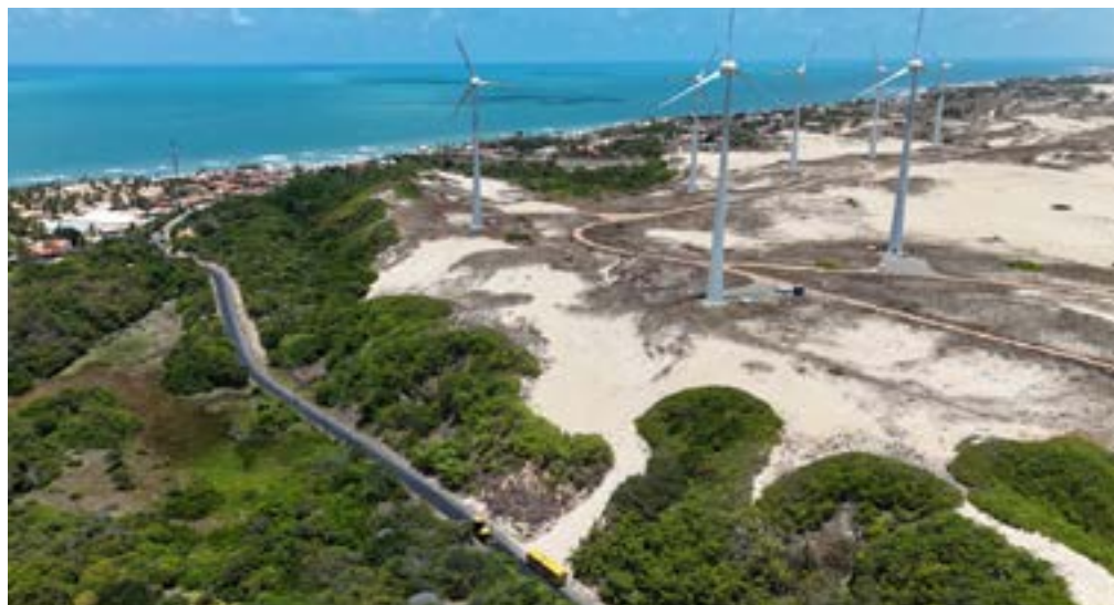
Pavimentação da CE-352 deve facilitar o deslocamento de moradores e turistas em direção à Praia das Fontes e à Praia do Diogo. Foto: Divulgação
