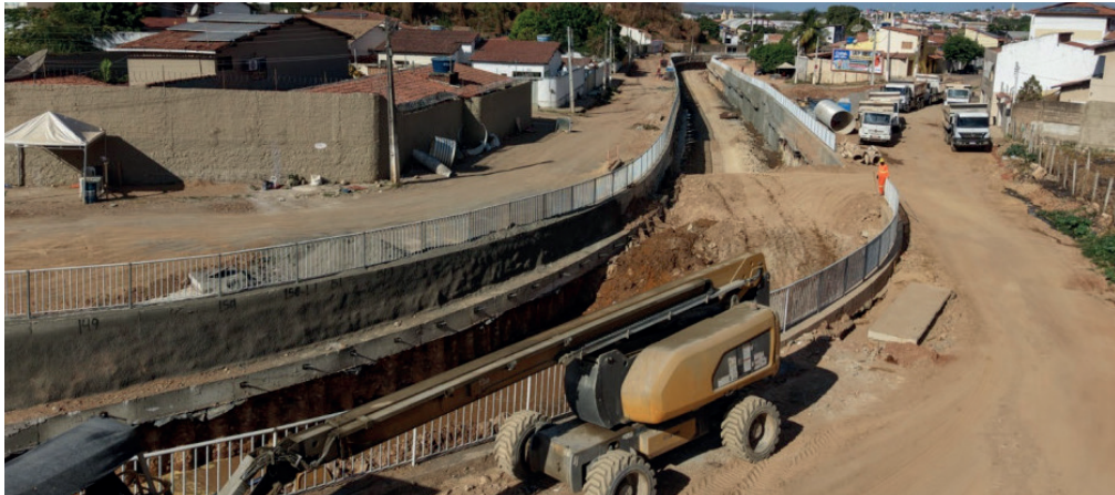
Obras no Canal do Rio Granjeiro incluem ampliação da vazão, reestruturação das galerias pluviais, bacia de amortecimento e vertedouro. Foto: Ascom SOP
