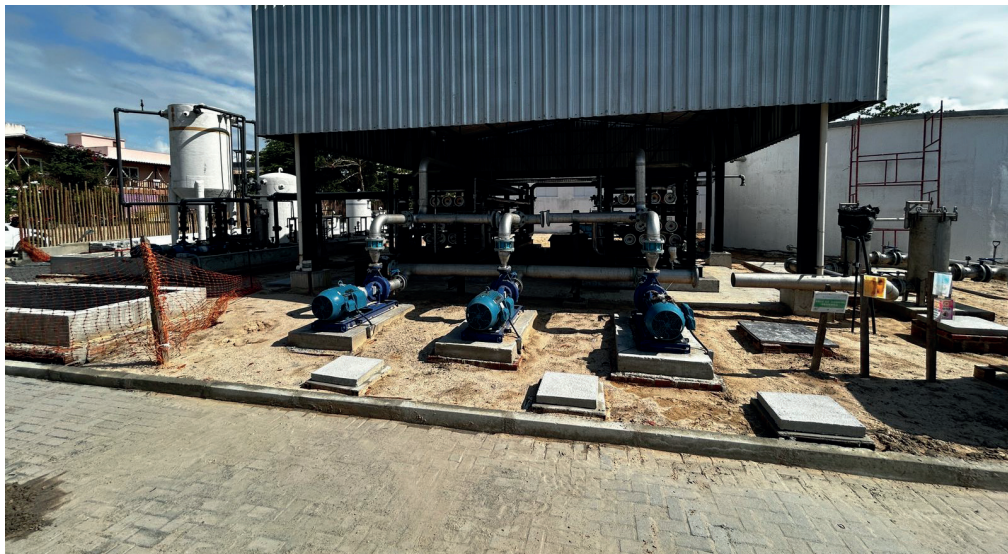
Quase 6 mil metros de tubulação serão substituídos ou implantados. Foto: Ascom Cagece
