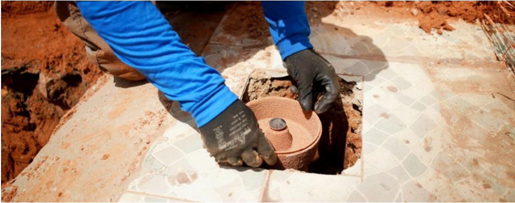
Segundo a Cagece, a interligação dos imóveis é essencial para transformar investimentos em benefícios reais para a população. Foto: Ascom Cagece
