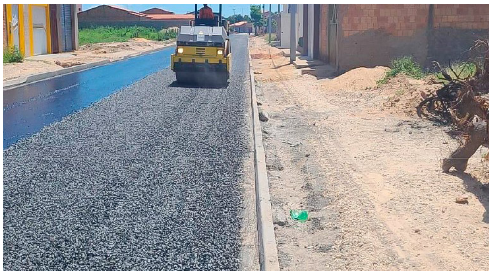
Autarquia assinou R$ 1,8 bilhão em contratos; 60% destinados a pavimentação. Foto: Rosinei Coutinho/SCO/STF
