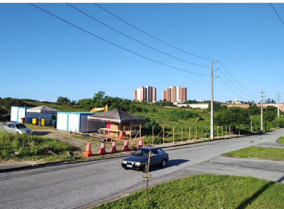
O canteiro de obras do novo data center está localizado no bairro Praia do Futuro, na Zona Leste de Fortaleza. FOTO: NATINHO RODRIGUES
