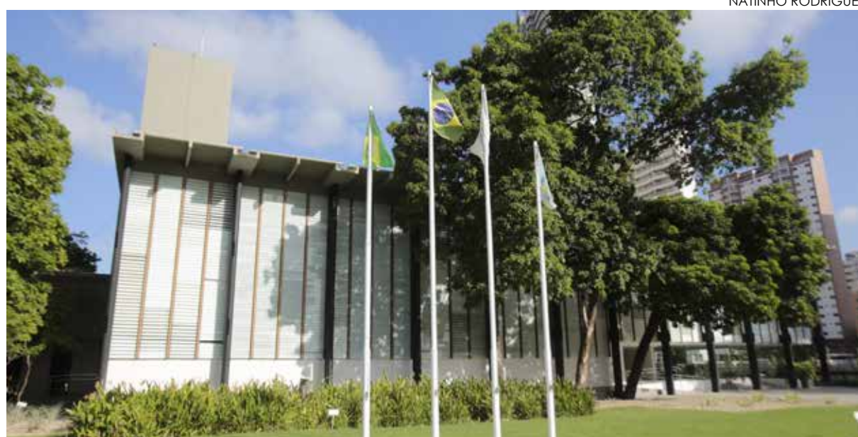
Palácio da Abolição, sede do Governo do Estado
